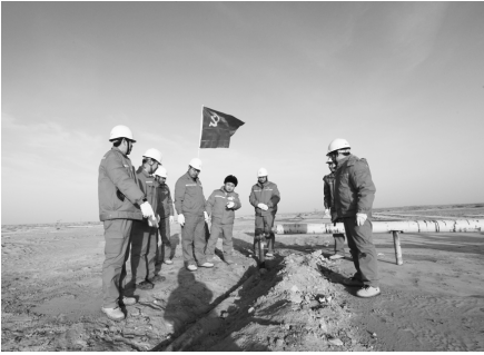
●党员查找TH12315井输油管线泄漏点。
