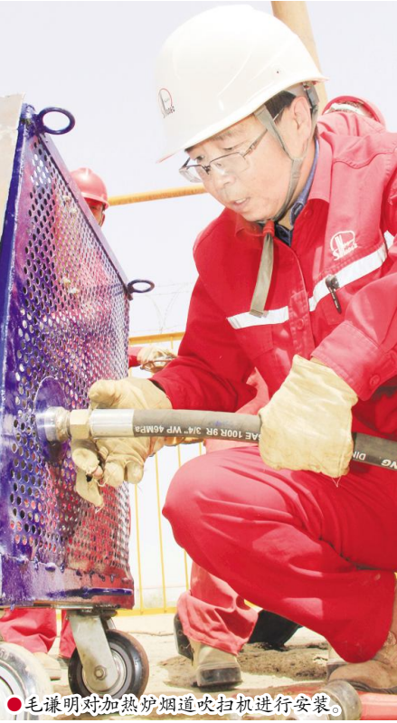
●毛谦明对加热炉烟道吹扫机进行安装。
