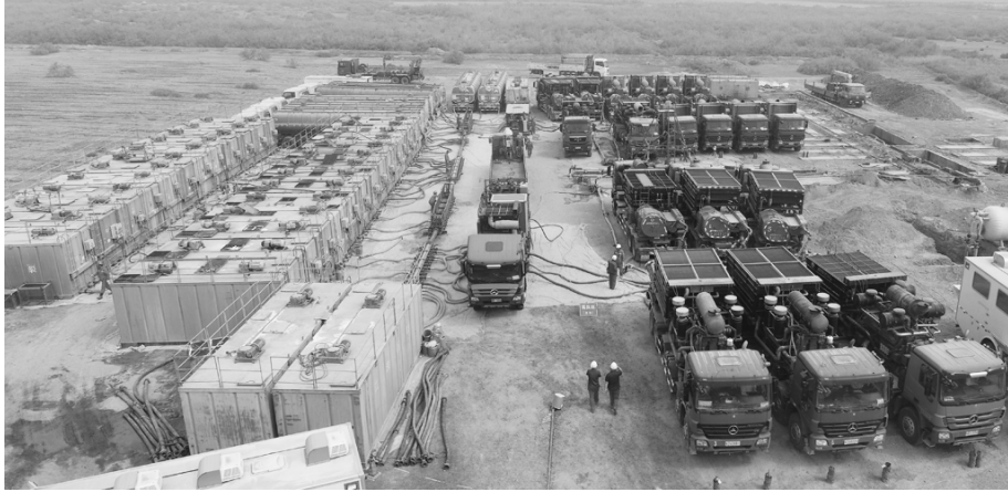
●TH12313CH2井大型酸压施工现场
