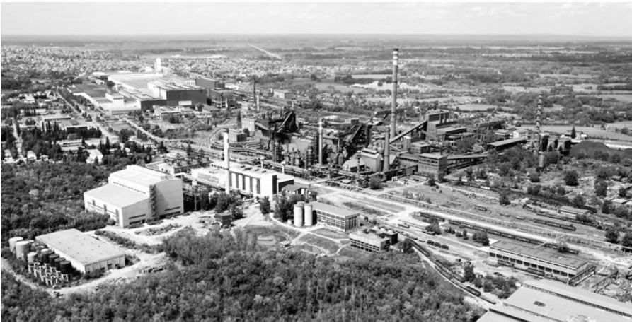
●河钢集团塞尔维亚公司航拍图
