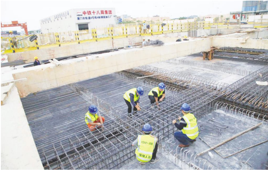
● 中铁十八局集团一公司地铁 4 号线洪坑站施工现场
