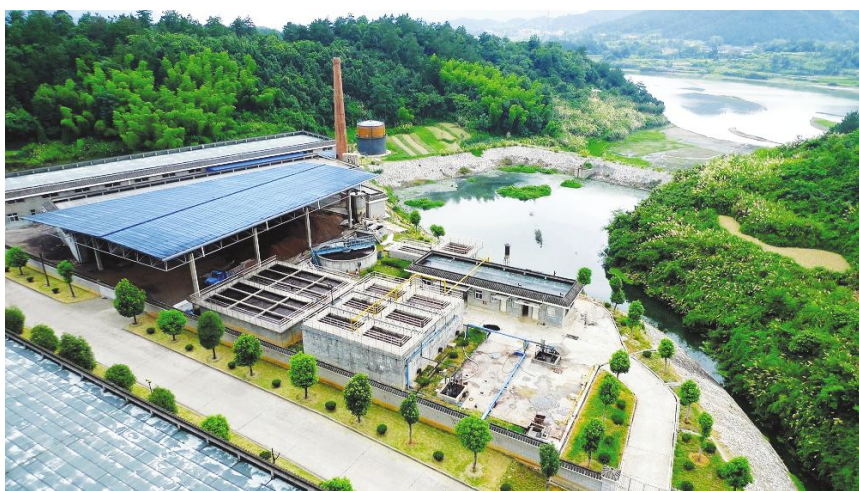
●原酒基地三期污水处理站
