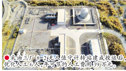
采油三厂8-2无人值守计转站建成投运后,优化用工6人,年可节约人工费用139万元。
