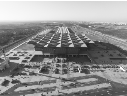
● 中铁十八局集团国际公司沙特工程公司承建的麦麦高铁麦加车站(伍振 万连余 摄)
