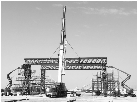
● 中铁十八局集团国际公司沙特工程公司朱拜尔 TS-8 高速公路项目龙门吊架设(伍振 徐名峰 摄)
