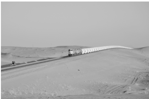
● 中铁十八局集团承建的中铁南北铁路荣获鲁班奖(伍振 万连余 摄)
