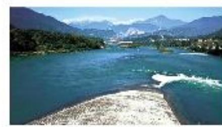
指导思想、“岁必一修”的管理制度，“遇弯截角，逢正抽心”的治河原则，以及“深淘滩，低作堰”的引水、防沙、泄洪之管理经验治堰准则。
