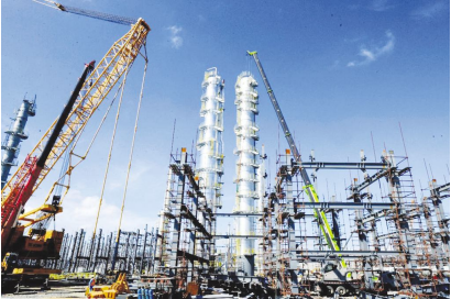
●塔器吊装现场
