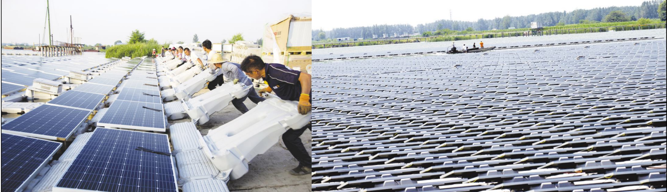
●技术人员在安装光伏板。
