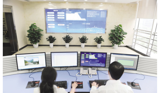
● 专业数据中心
