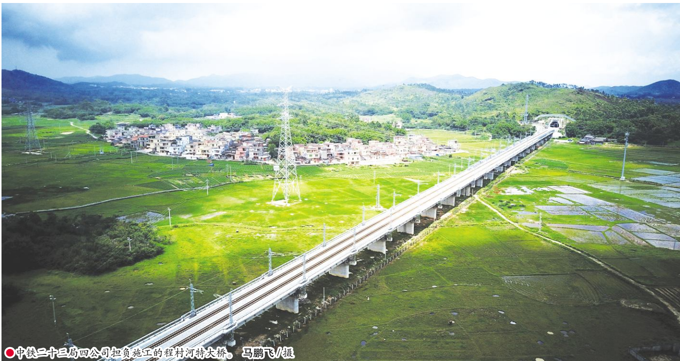
●中铁二十三局四公司担负施工的程村河特大桥。马鹏飞/摄
