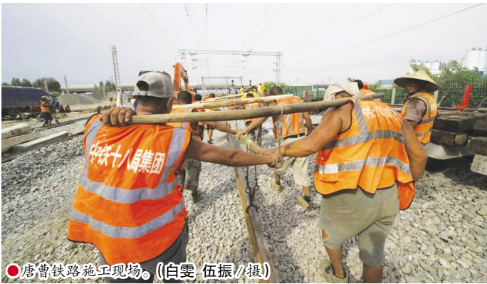
●唐曹铁路施工现场。(白斐 伍振/摄)
