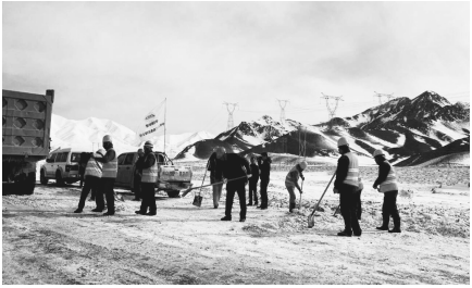
作业人员清理路面积雪
