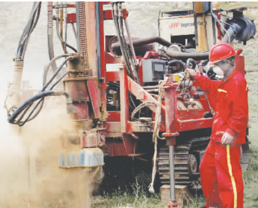
正在施钻的履带钻井作业现场
