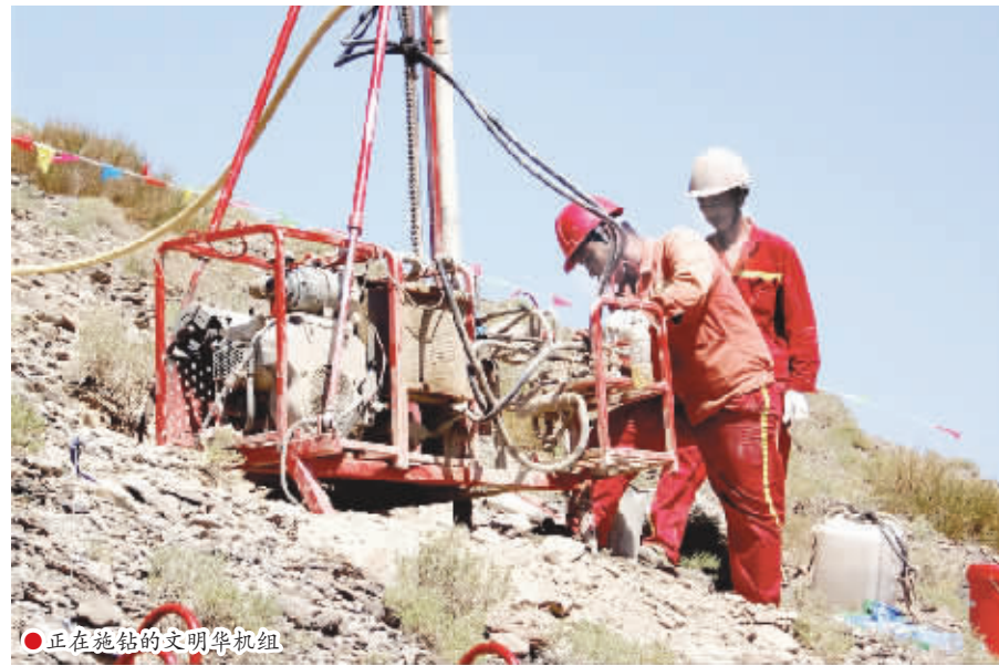
正在施钻的文明华机组
