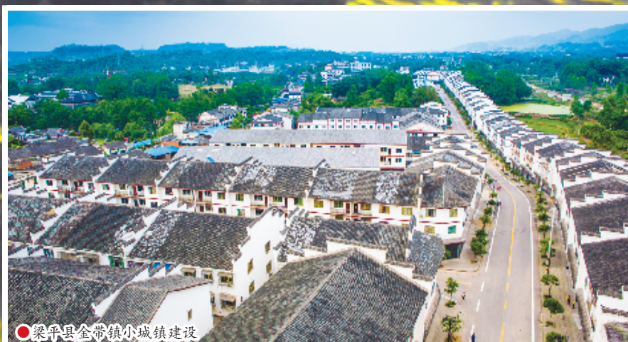
● 梁平县金带镇城镇化建设
