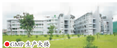
●GMP 生产大楼
