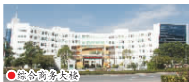
●综合商务大楼
