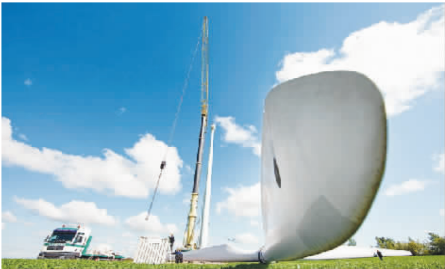
●德国可再生能源迅猛发展,图为德国能源供应商 ENERTRAG 在安装风力发电机。
