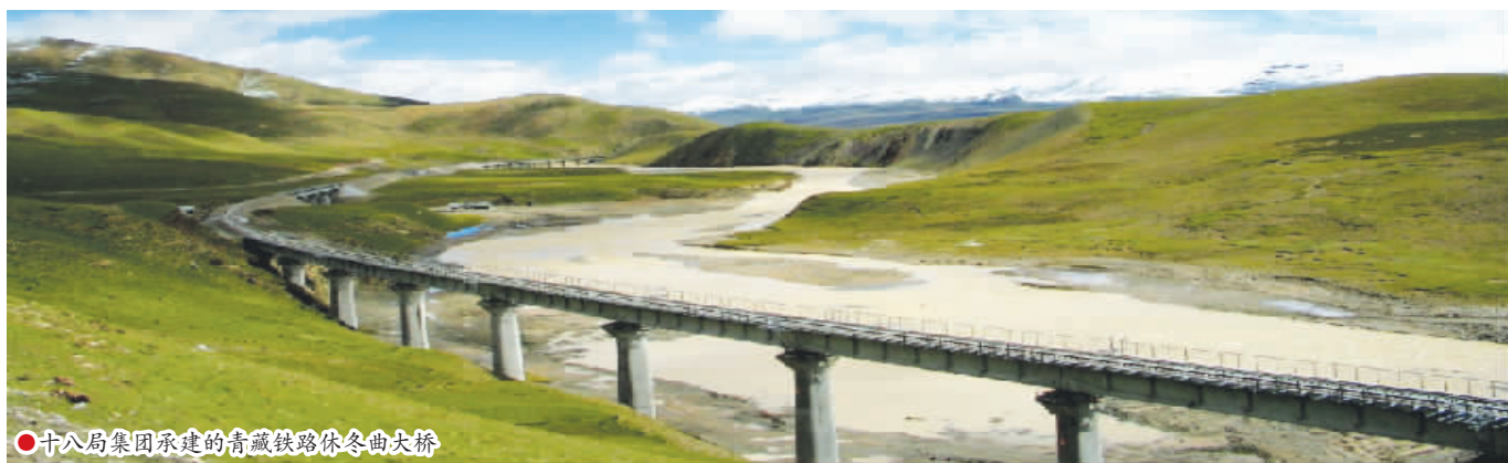
●十八局集团承建的青藏铁路休休曲大桥
