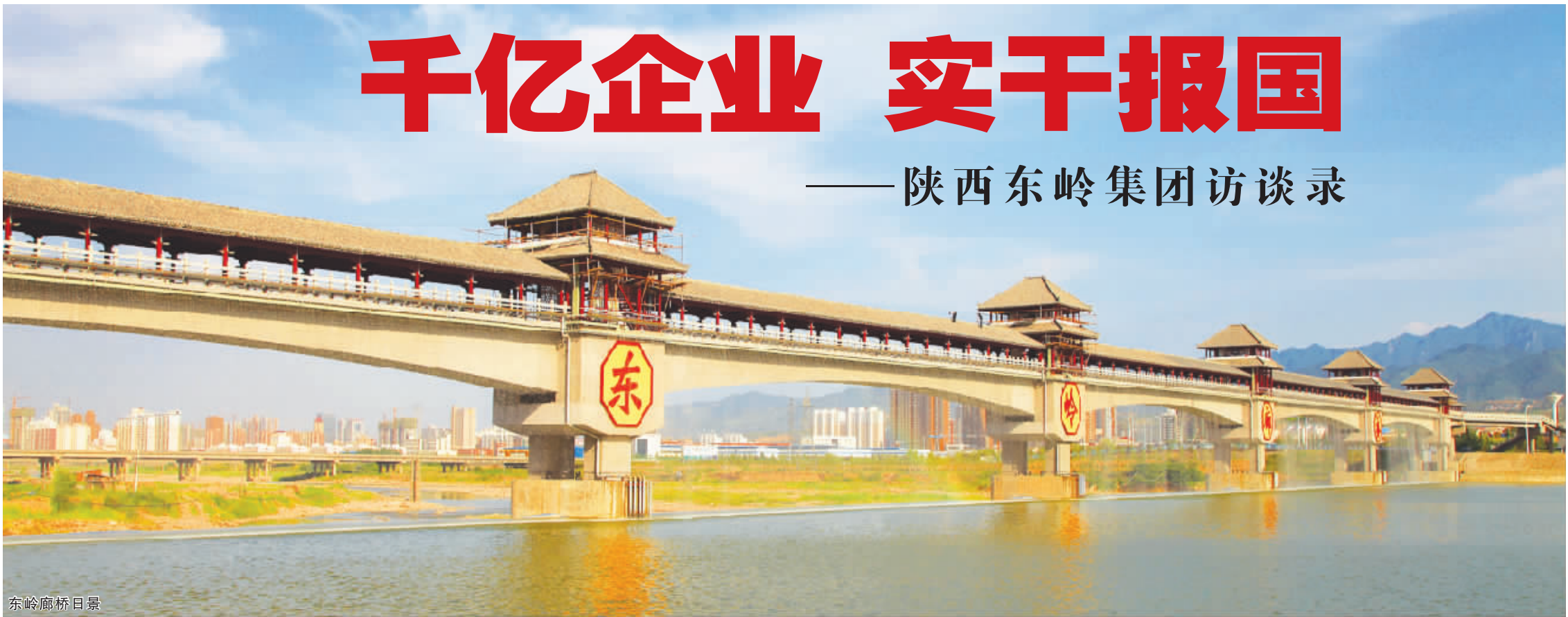
东岭廊桥日景
