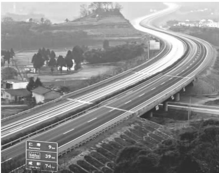
期间,仁寿县境内从无到有,已建成2条高速公路。已建高速公路124公里,在建高速公路67公里,完成投资101.3亿元。高速公路途经仁寿县60个乡镇中的34个,共设17处落地互通。高速公路对仁寿乡镇的覆盖率已经远远超过周边区县。截至2015年底,成都经济区环线高速公路仁寿段已完成投资23.1亿元,占总投资的47.3%。其中,路基土石方完成1821万立方米,桥基桥台累计完成1901根(座),梁体累计架设1620片,涵洞施工完成8043米。仁沐新高速公路和天府仁寿大道清水至三绕段也在顺利推进中。
