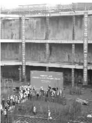
●混凝土浇筑仪式现场
