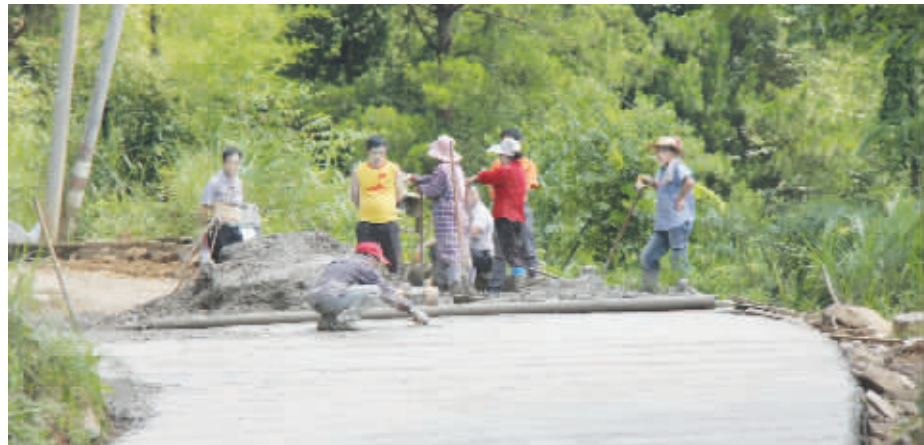
● 公路建设施工现场
