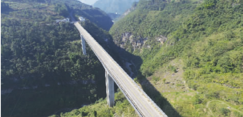
● 国道319线彭水郁山特大桥
