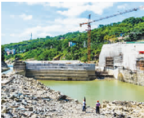
●盖石涧电站增效扩容工程有序推进(陈宗武 摄)
