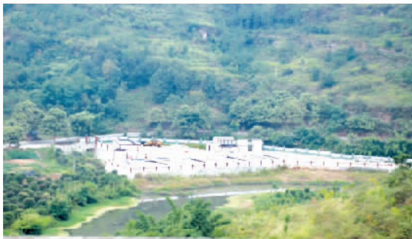
●三角污水处理站。
