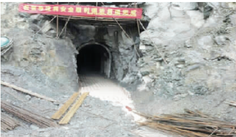
●茶树湾水利工程导洞衬砌完工。
