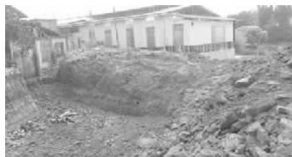
●投资亿元的白酒文化产业施工现场
