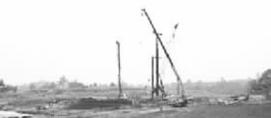
●南溪变电站建设现场
