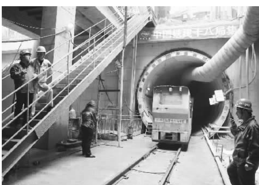
羊年春节,中国铁建十八局集团轨道公司深圳地铁7号线项目经理钱浩(左一)带领建设者们依然在坚守,深圳地铁7号线建设进入冲刺阶段。
