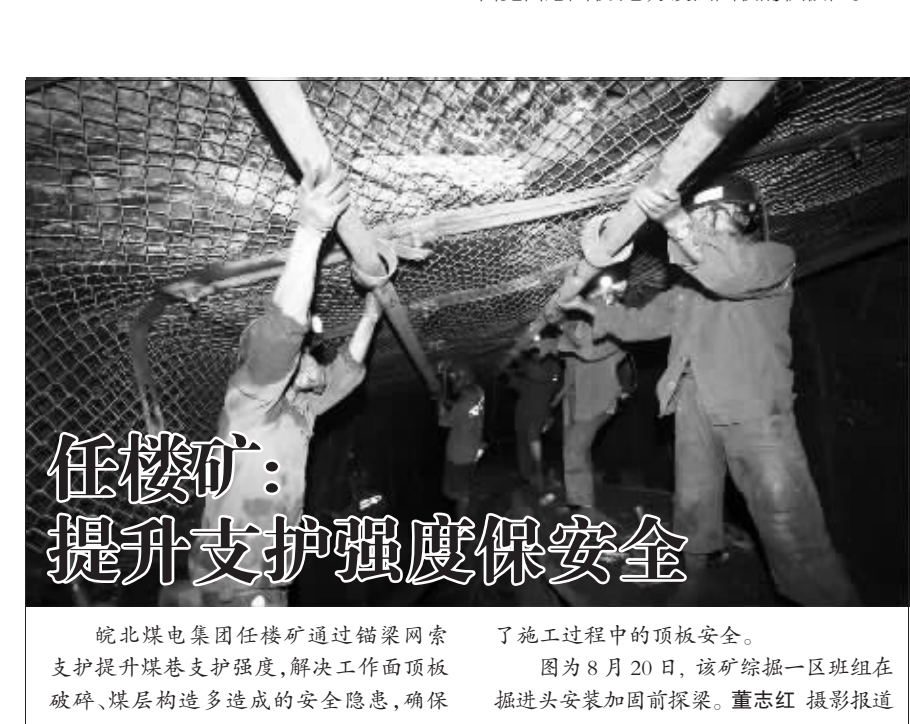
皖北煤电集团任楼矿通过锚梁网索支护提升煤巷支护强度，解决工作面顶板破碎、煤层构造多造成的安全隐患，确保了施工过程中的顶板安全。
