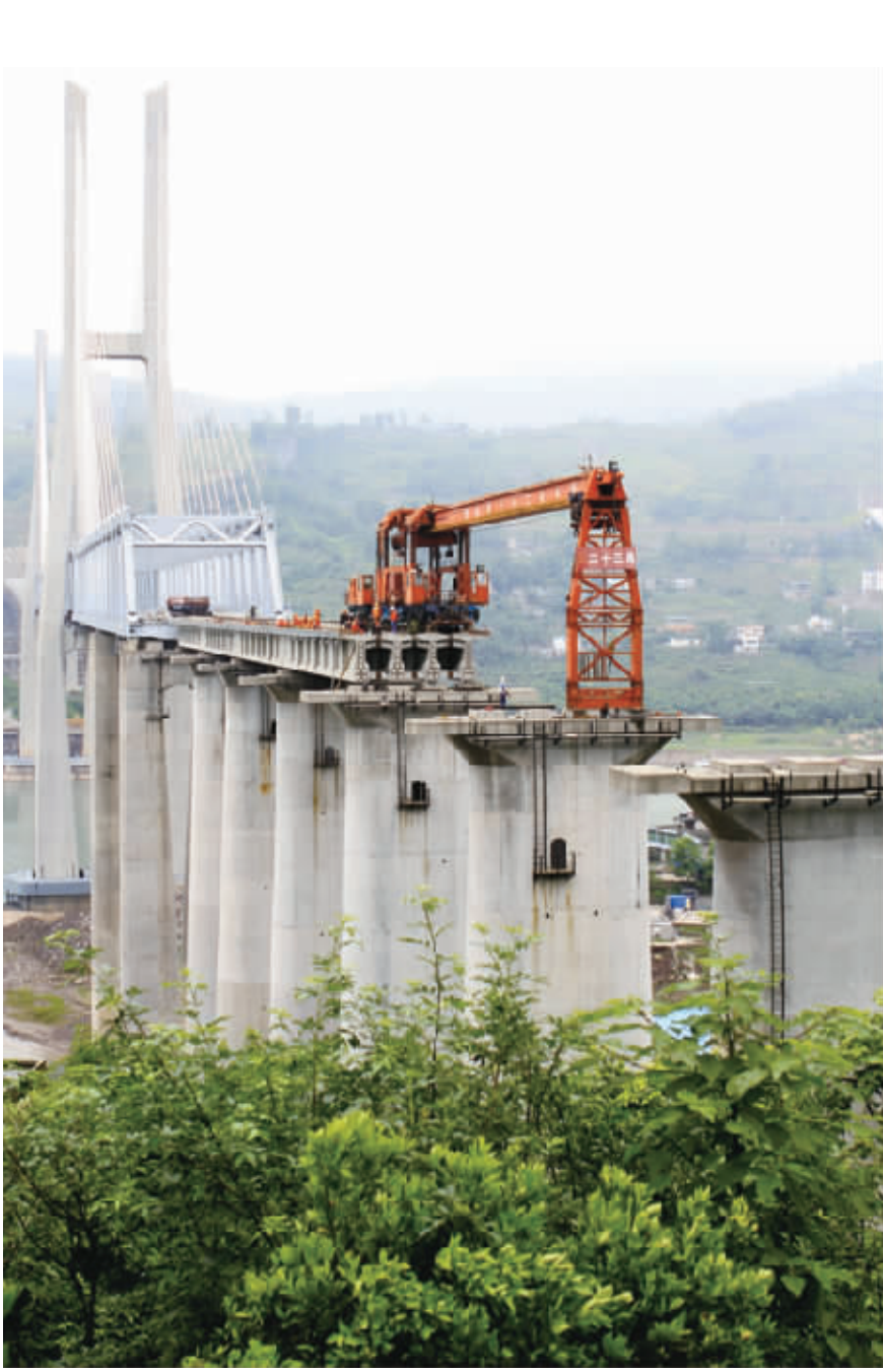
●2013年5月20日韩家沱长江大桥架梁
