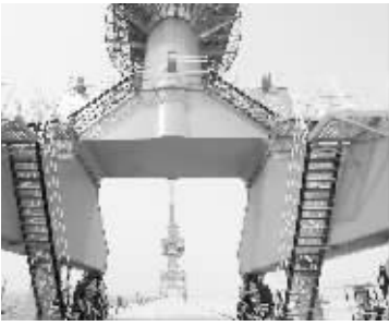
◎首钢京唐钢铁厂
