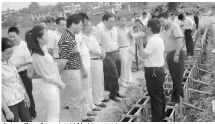
参会人员观摩“双面立模”钢模施工现场
