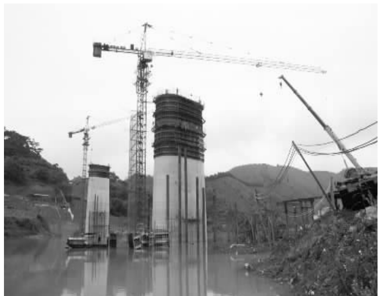
▲图为南广铁路石头步大桥现浇梁施工现场一角。张光林摄
