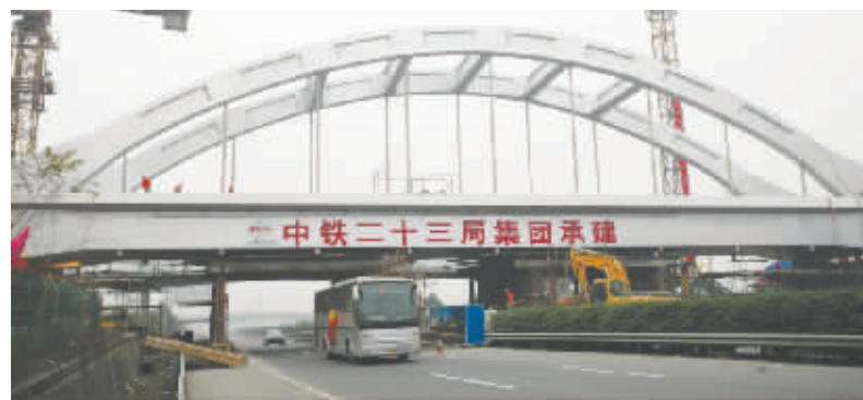
成昆铁路货车外绕线绕城高速立交双线特大桥——国内最重横移梁成功顶推就位。
