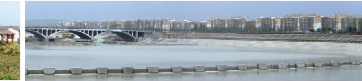
○山东援建的新北川县城
