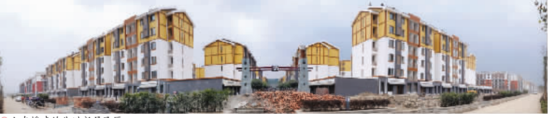
◎ 山东援建的北川新居民区
