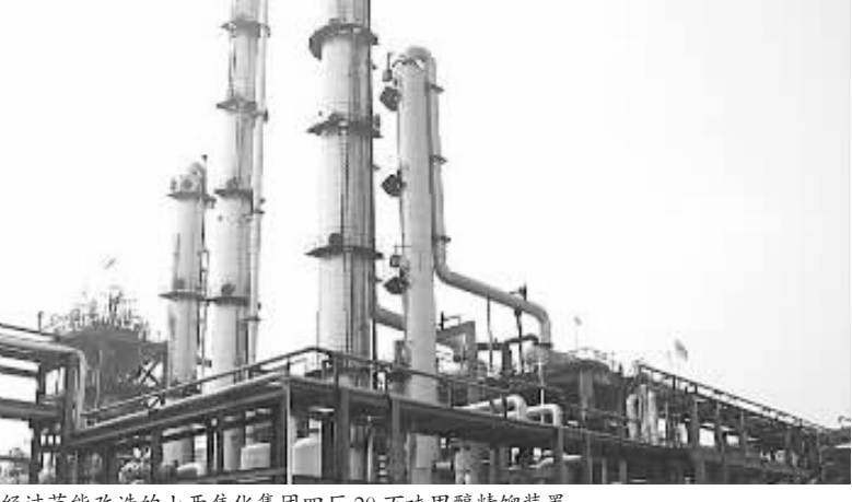
◇ 经过节能改造的山西焦化集团四厂20万吨甲醇精馏装置
