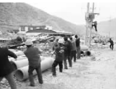
四川移动救援队争分夺秒抢架通信线路。
