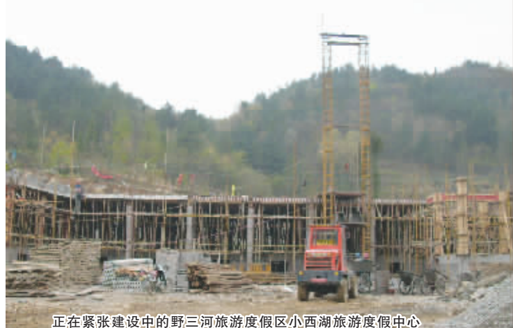
正在紧张建设中的野三河旅游度假区小西湖旅游度假区中心
