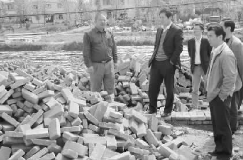
黎处长（左二）视察烤房建设。
