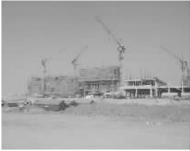
▲建设中的临洮中铺的水泥生产线
