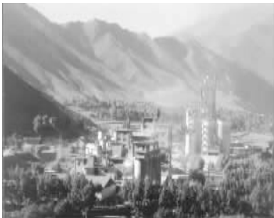
▲正在抓紧建设的夏河安多水泥生产线
