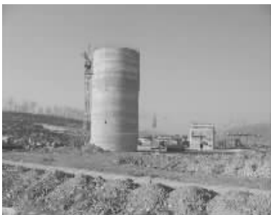
▲建设中的临夏买家集的水泥生产线
