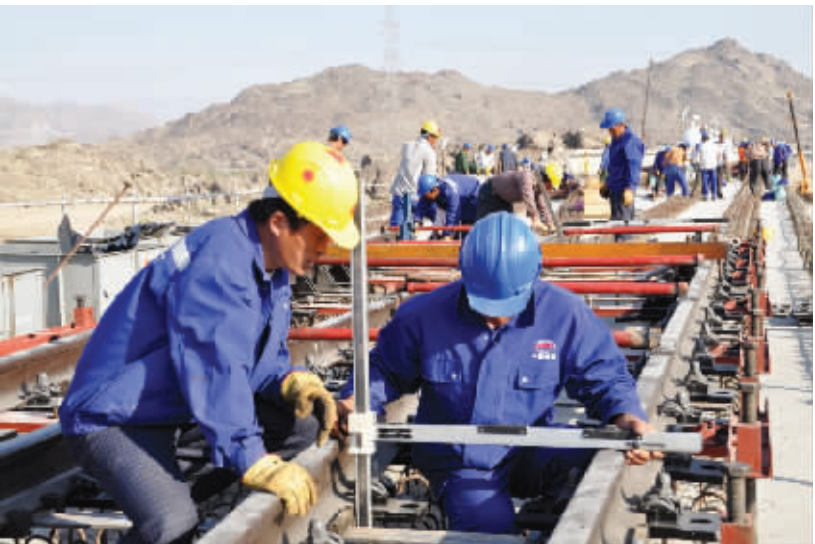
中铁十八局集团沙特麦加地铁项目职工以胡总书记讲话精神为动力掀起施工高潮，图为职工们正在精心施工的无砟轨道。
