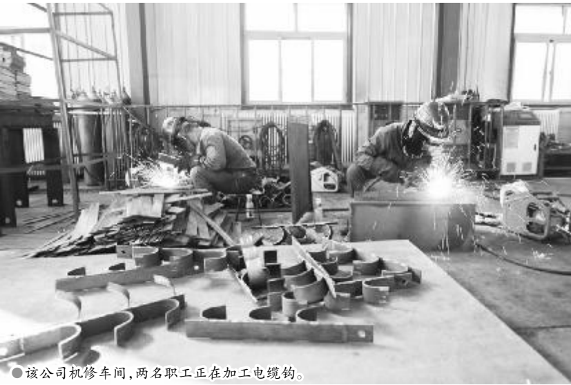
● 该公司机修车间,两名职工正在加工电缆钩。
