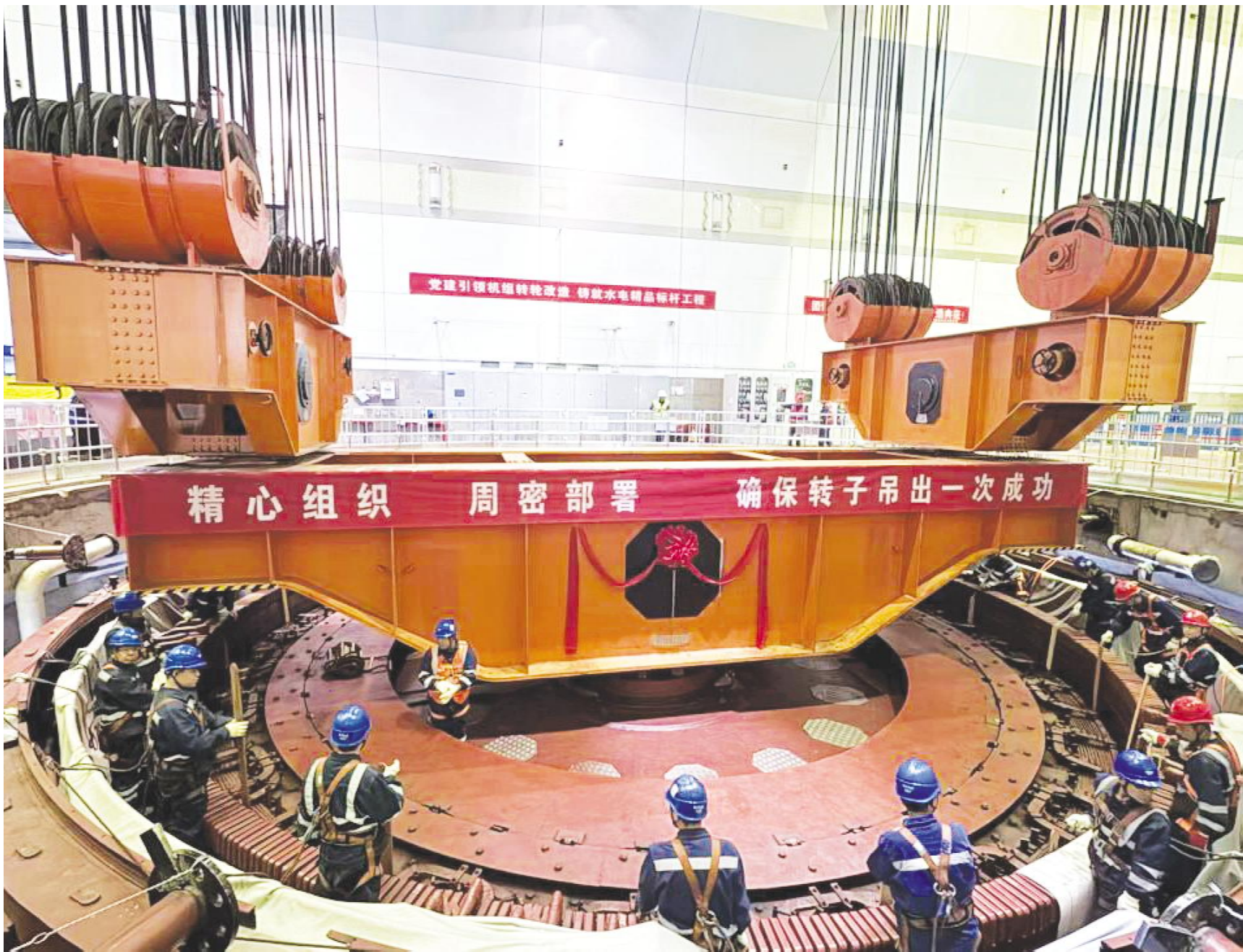
● 9月23日，检修公司李家峡项目部开展李家峡水电站2号机组吊转子作业。
