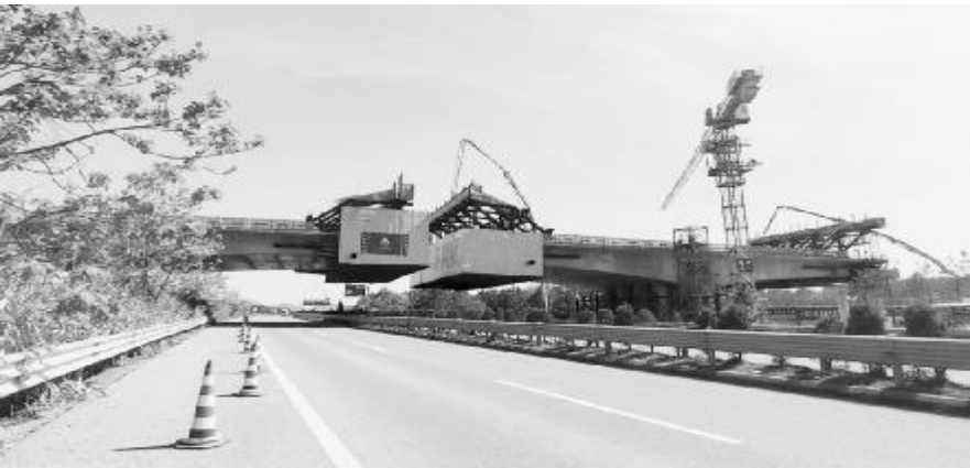
●项目施工现场
