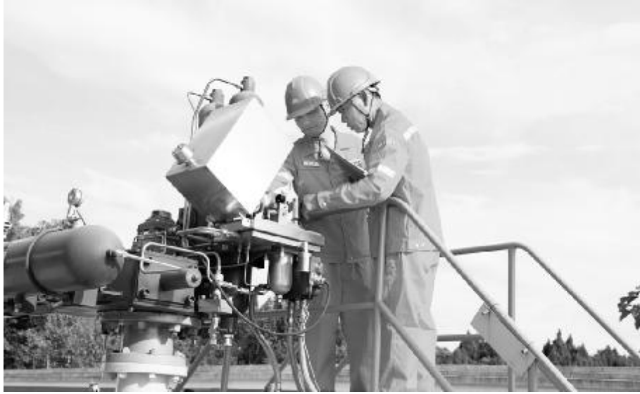
●采气员工检查气流联动球阀，确保平稳供输。
