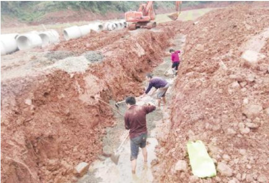
●枳壳种植基地管道安装
