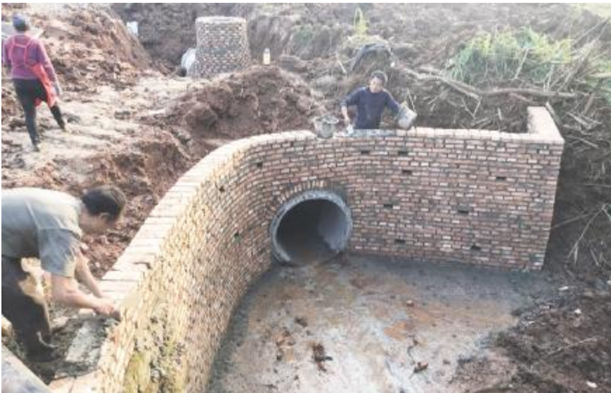
●基地管道安装
