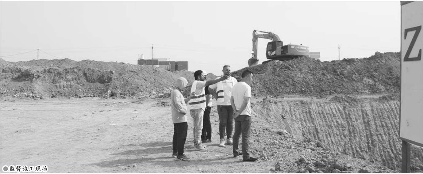
● 监督施工现场
