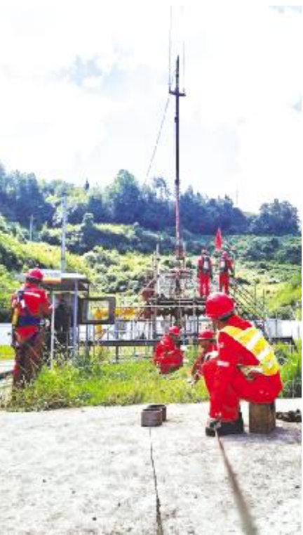
●员工进行修井作业。
